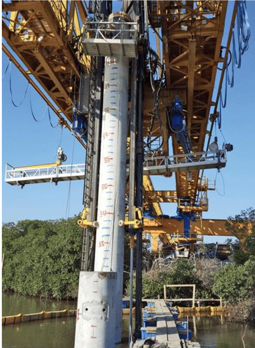
Un particolare della battitura dei pali del pulvino tipico
