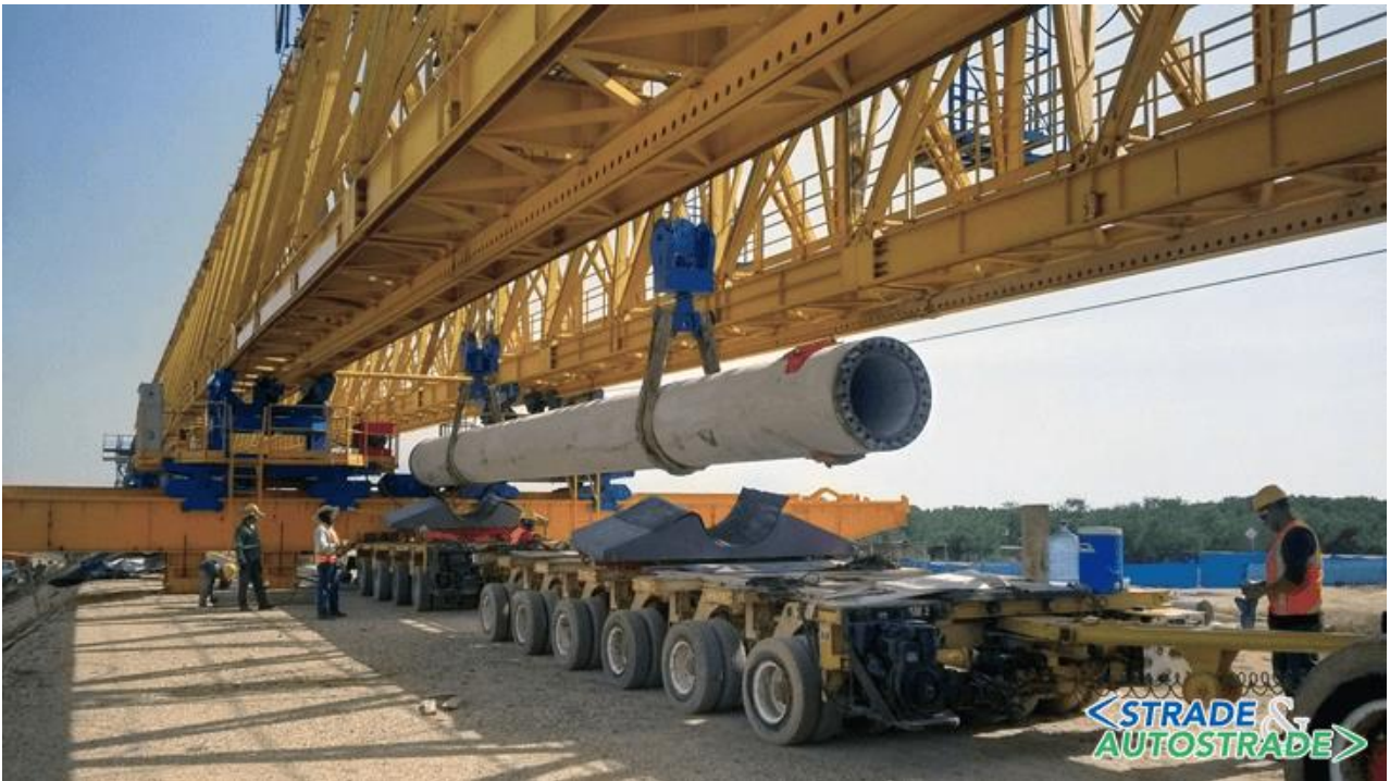
Il prelievo dal rimorchio del palo prefabbricato
