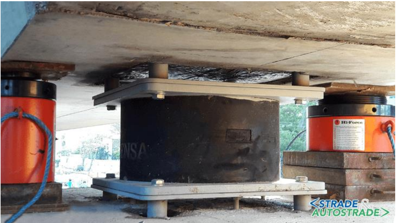
Un particolare dell'installazione degli appoggi
