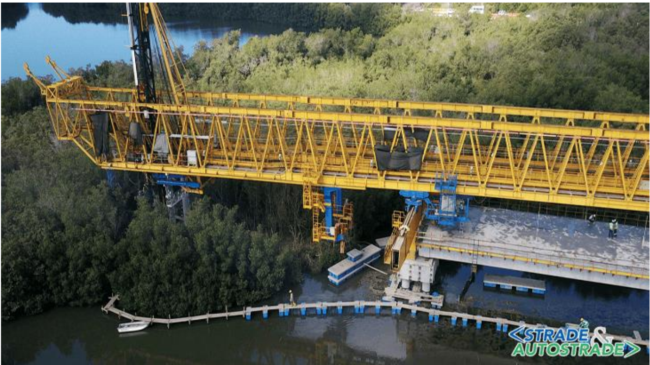
L'area di lavoro durante la battitura nella quale si vede la costruzione top-down che permette un impatto minimo sull'ambiente circostante
