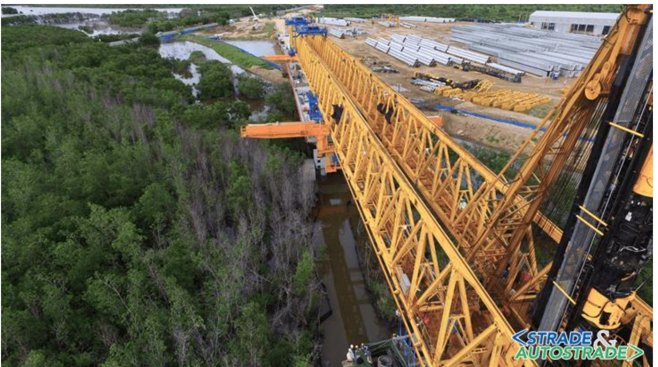
Le prime fasi di costruzione: qui, la spalla di Barranquilla
